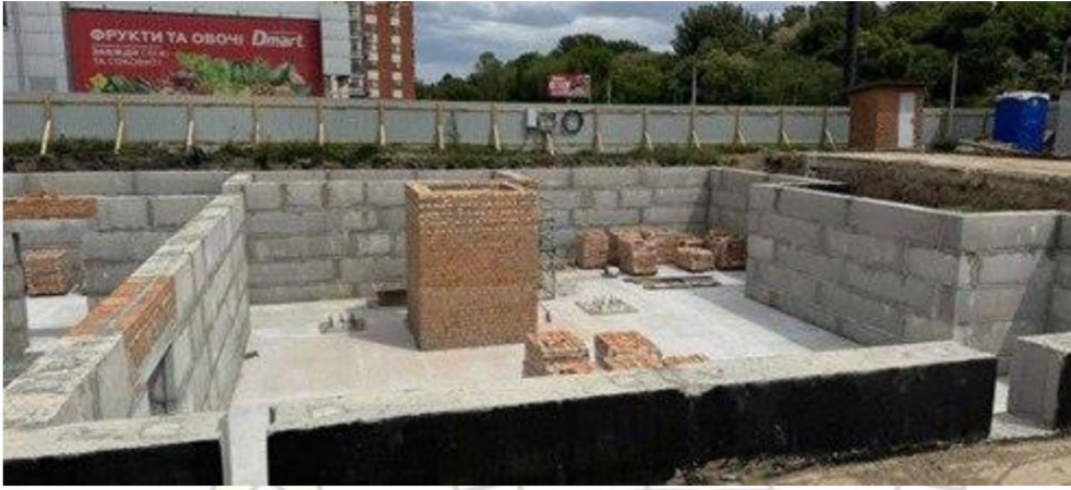
Фото нового будівництва ЦНАПу в сщ. Слобожанське
