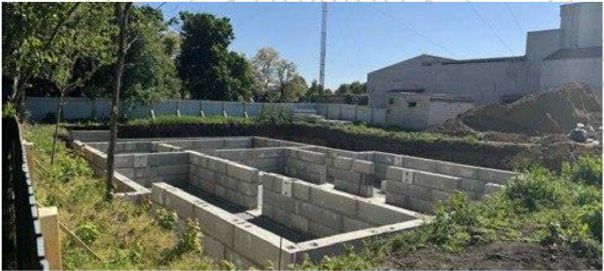
Фото нового будівництва амбулаторії в с. Олександрівка
